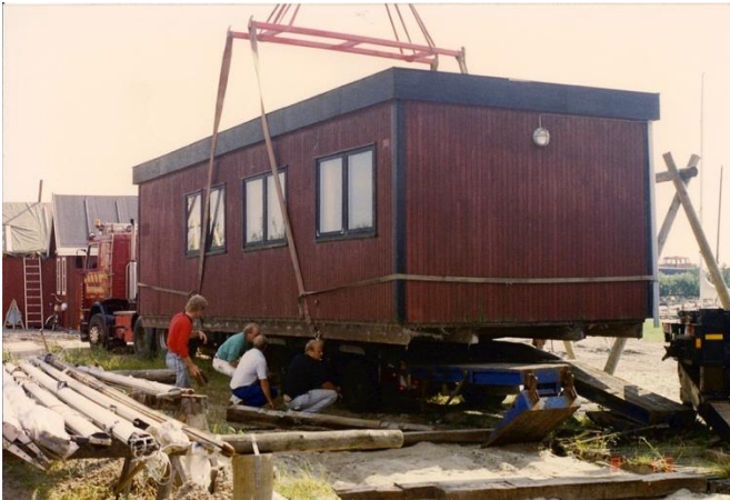
På billedet her løftes det skur, der brugtes som midlertidigt klubhus, af havnens kran for at blive placeret ved siden af det nye klubhus og her ombygget til havneshoppen "Sjækelen".
